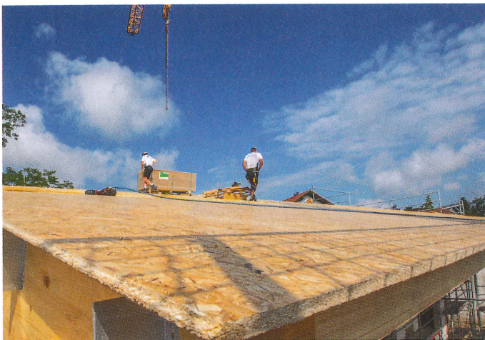
▲ Mehr als 2000 m 2 SterlingOSB/3-Zero hat die Holzbau Rehm GmbH als Untersicht und Dachschalung im Satteldach der neuen...
