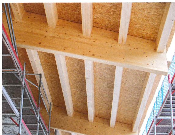
▲ Mehr als 2000 m 2 SterlingOSB/3-Zero hat die Holzbau Rehm GmbH als Untersicht und Dachschalung im Satteldach der neuen...
