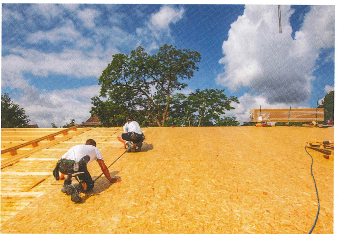
▲ ...Schalung für einen Dachstuhl verarbeiten
