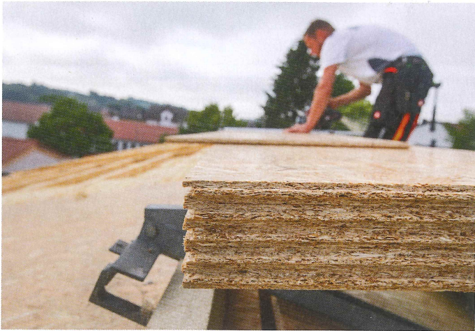
▲ Ausgestattet mit einer Nut- und Federverbindung lassen...
