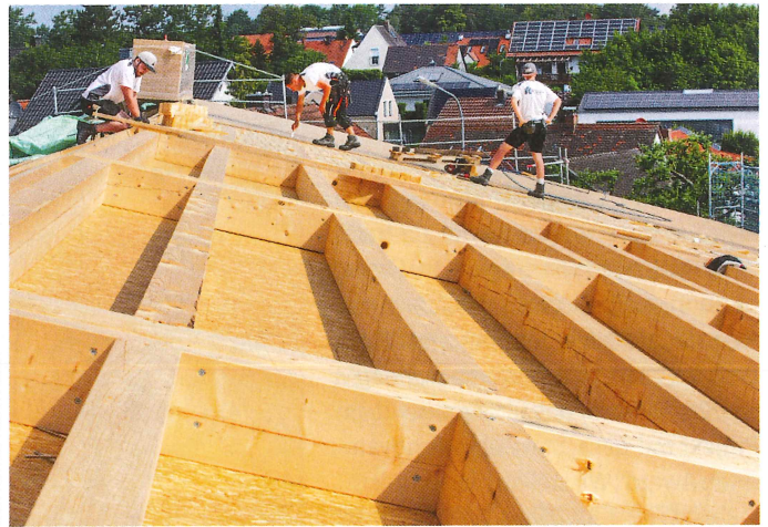
▲ ...Lagerhalle vom Bauhof der Markt Ergoldsbach verbaut. Die Platten entsprechen der Norm EN 300 und...
