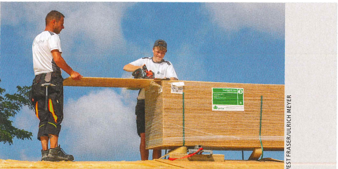
▲ Abgelängt wurden die OSB-Platten mit einer Handkreissäge und befestigt...
