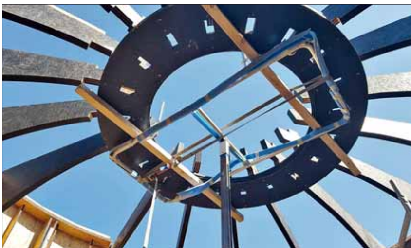
Die Dachkonstruktion hat Ackermann als stabiles Steckverbindingssystem ausgeführt. „Die gesamte Konstruktion ist nach der Montage hoch belastbar“, so Ines Löffler, kaufmännische Projektleiterin bei Ackermann.
