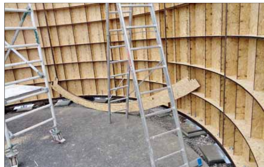
Um die OSB in die gewünschte Form biegen zu können, wurden sie von Ackermann per Lasercut geschlitzt, die Platten wurden dann später noch schwarz angestrichen.
