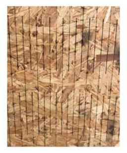
44 SterlingOSB-Platten, 7 km Laserkanten, 13 Lärchenplatten, eine Dachfläche von 36 m<sup>2</sup> - hinter diesen Zahlen verbirgt sich ein ganz außergewöhnliches Holzbauwerk, das die Ackermann GmbH entwickelt, konstruiert und gebaut hat. Mitten in den Weinbergen bei Thungersheim am Main erhebt sich über den Muschelkalkbänken auf einem schneckenförmigen Fundament der Pavillon, der über Wein und Weinanbau im Frankenland informiert.
